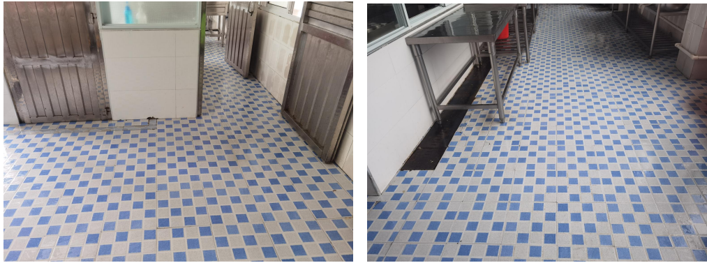
食堂操作间地面图片
