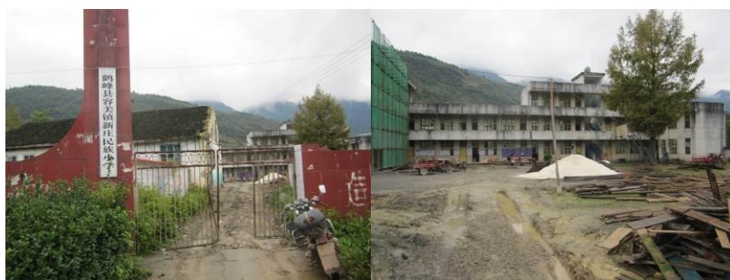
图 1-2 新庄民族小学原址在施工
