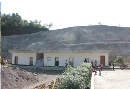
图 2 学校后面的山坡已经加固
