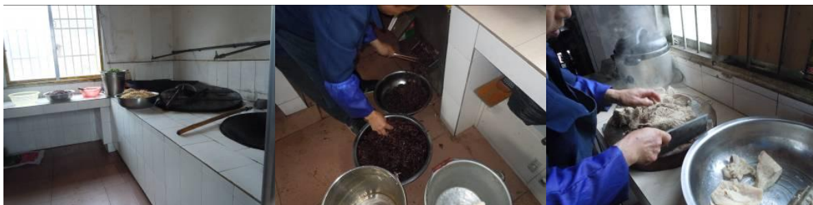
图五 厨房现状
