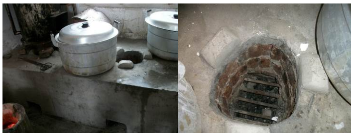
图 11 尚未启用的新煤炉灶
