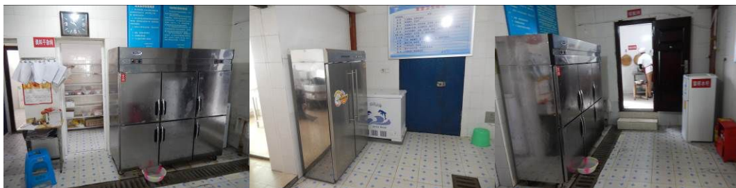
图 18 正常使用的厨房设备组图
