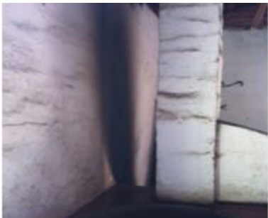
图 7 厨房墙面卫生情况图
