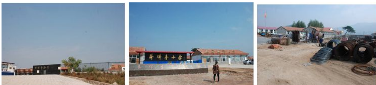
图 1 学校外观（学校正在建新教学楼）
