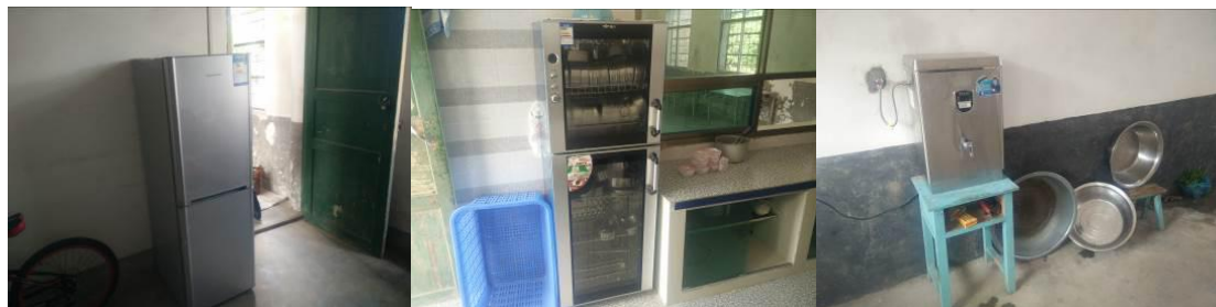
图 16 正常使用的厨房设备组图
