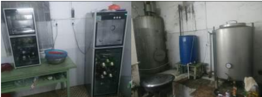
图 13 正常使用的厨房设备组图
