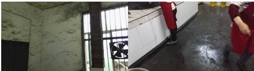
图4 厨房墙面和地面卫生组图
