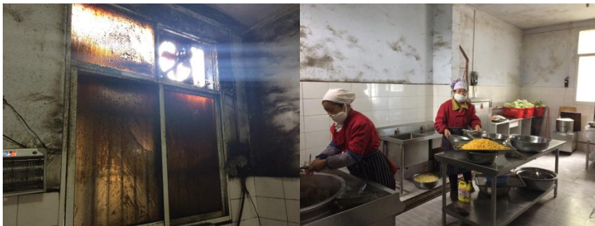
图 5 灶台上方窗户及操作间全景
