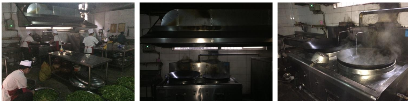
图4 操作间全景及局部
