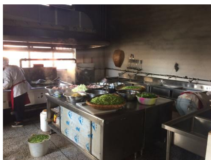
图 4 操作间全景(示墙面情况)
