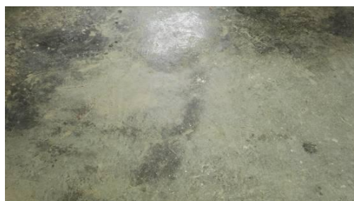
图 5 厨房地面卫生图
