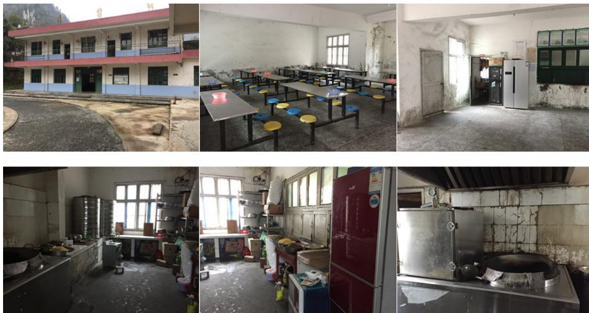
图 4 厨房卫生情况组图 (厨房墙面卫生差, 操作台卫生一般)
