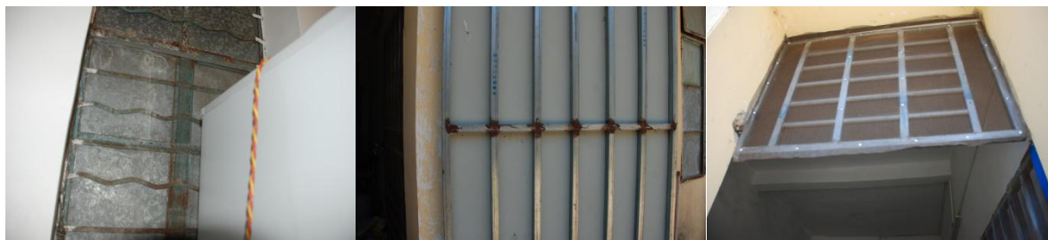
图 13 学校厨房门窗加固及排油烟机组图
