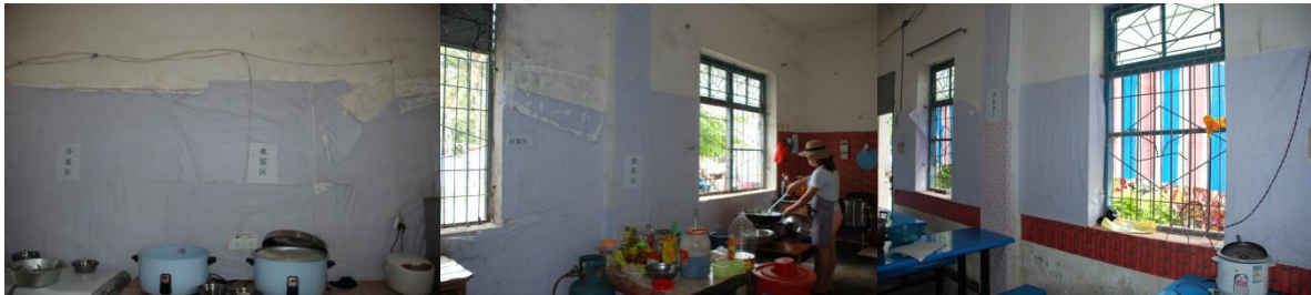
图 18 学校厨房墙面情况图组
