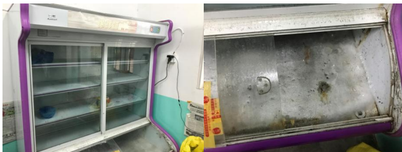
图 6 冷藏冷冻设备内部情况
