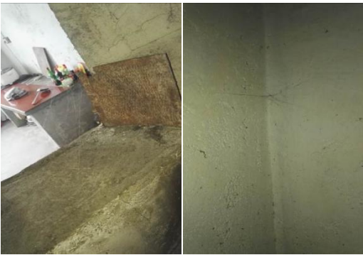
图 6 厨房墙面卫生情况组图
