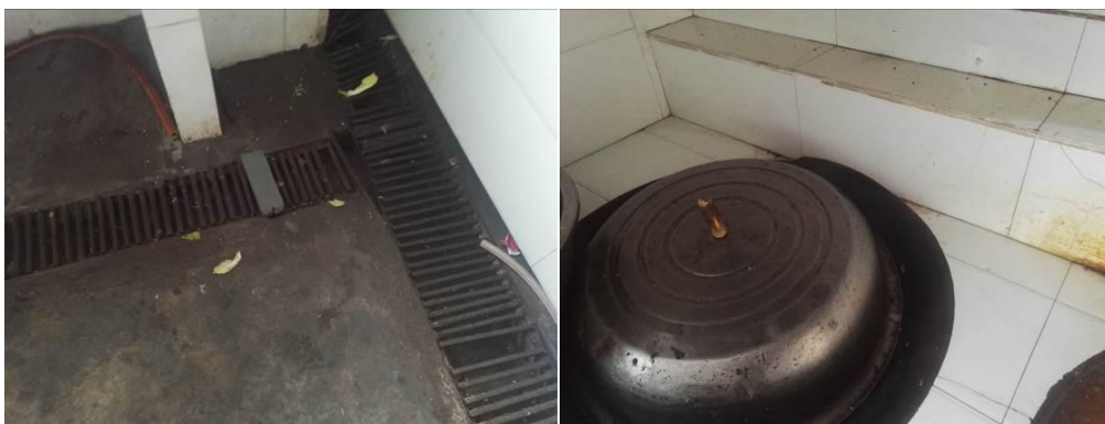
图 4 厨房卫生情况组图
