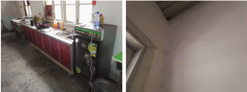
图 I -1 厨房卫生情况组图
