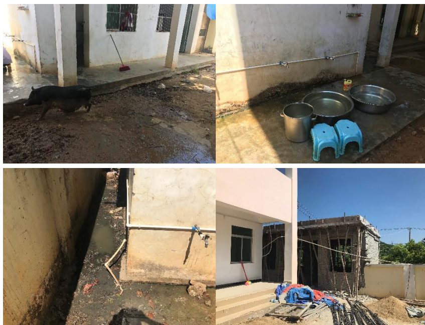
图 I -6 厨房周边环境及在建厨房组图
