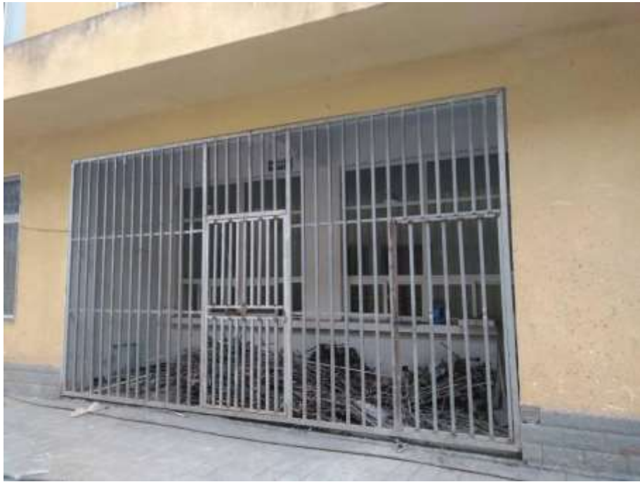
（即将施工完成的学生新食堂）
