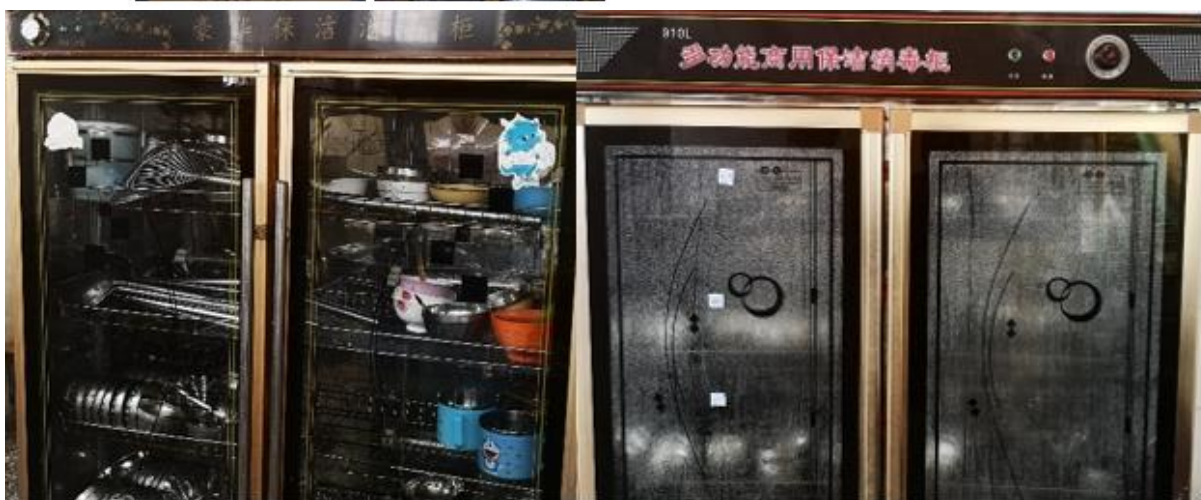
学校现有两台消毒柜，均正常使用
